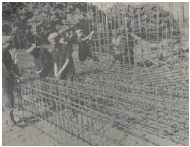
កម្មករនៅស្រុកមង្គលបុរី ភូមិភាគពាយ័ព្យ កំពុងចងដែកយក ទៅធ្វើទារទឹក។ (បណ្ណសារមជ្ឈមណ្ឌលឯកសារកម្ពុជា)
